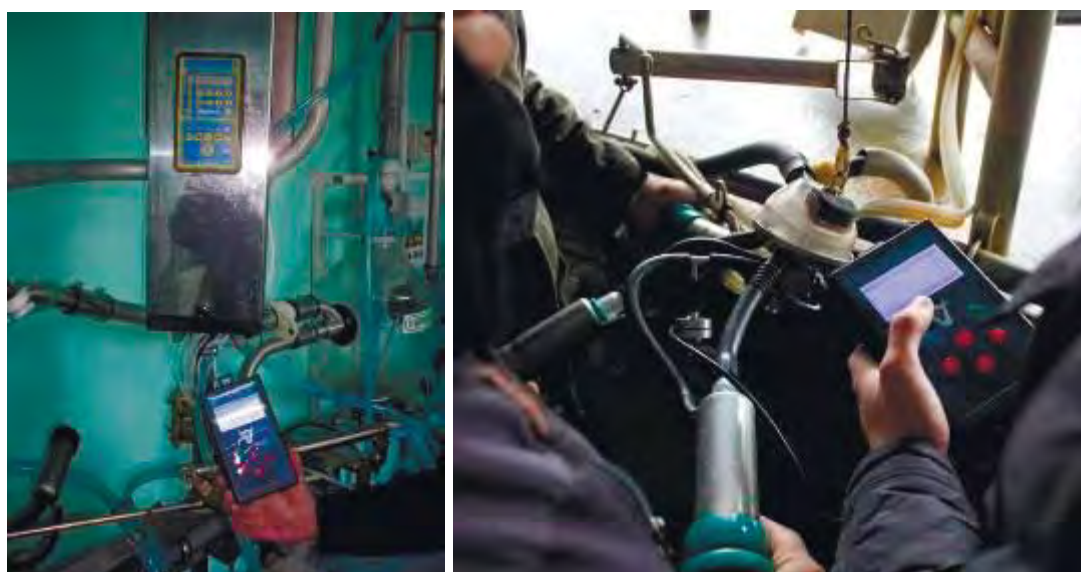
Рисунок 4 – Комплект приборного оборудования в производственных условиях
